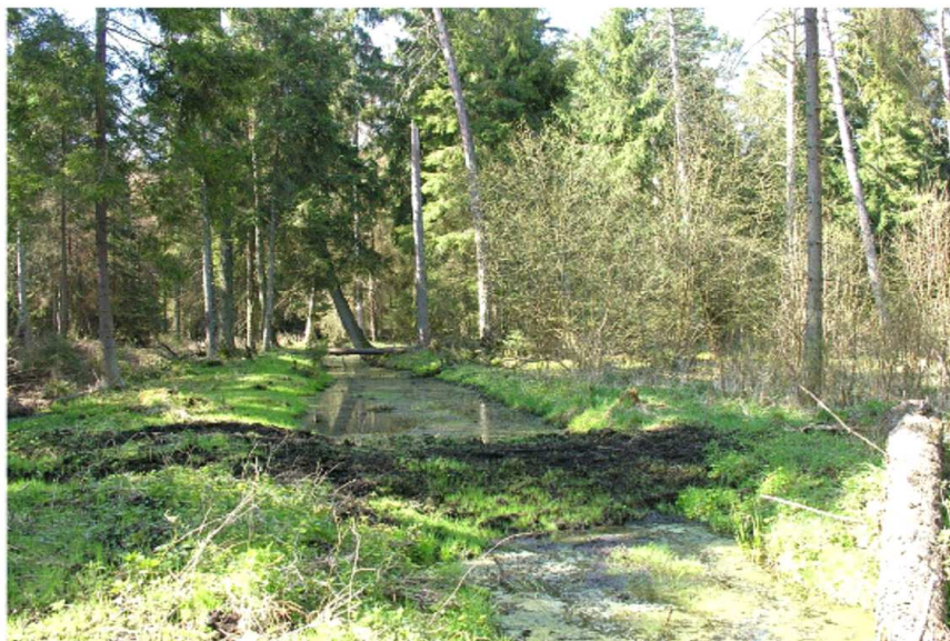
Rycina 33. Przetamowania ziemne rowów odwadniających (Projekt. Mała retencja w lasach...)
