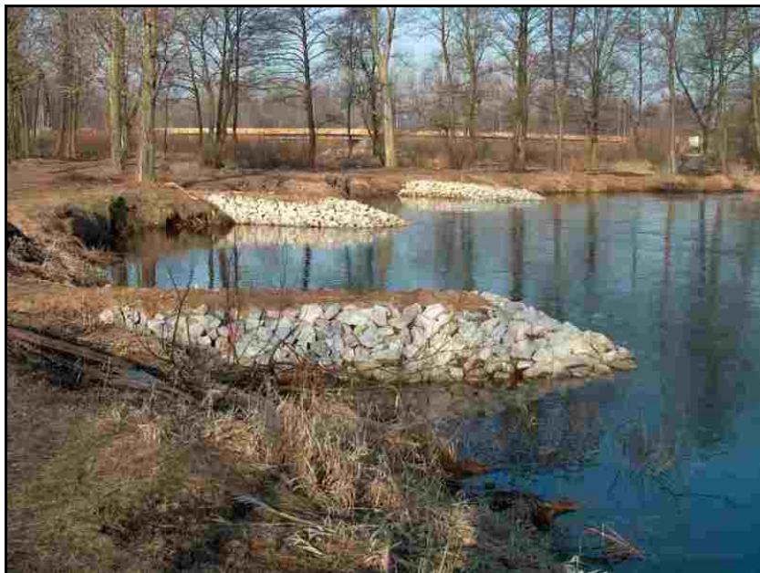
Rysunek 5.1.5. Przykład odtworzenia budowli regulacyjnych poprzecznych (ostróg), widoczne materiały naturalne - faszyna, kamień, koronki wiklinowe
